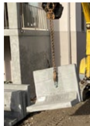
Mitte und rechts: Doppelte Sichtseite, schalungsglatt. Vorne: Individuelles Element gestraht, mit geneigter Krone.
