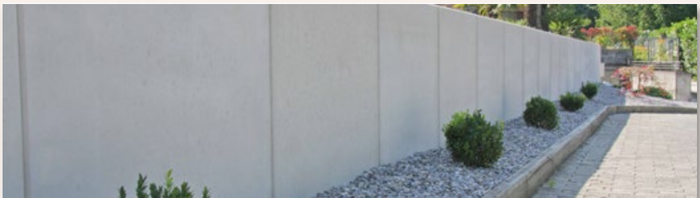
Mauerscheiben, Sichtbeton grau
