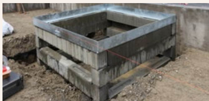
Pflanzgrubenelement Typ 120 mit Einbaurahmen Typ 312
