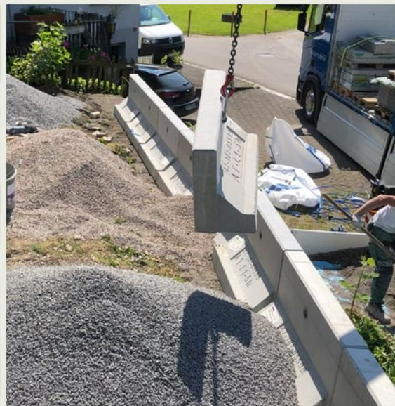
Wenns auf der Baustelle mal wieder schnell gehen muss und die Sicherheit dabei nicht zu kurz kommen darf: Winkelplatten duplex sind dank dem praktischen Kugelkopfanker ca. 25–30 % schneller versetzt (und sicherer!) als Mauerscheiben mit Winkelschlaufen.
